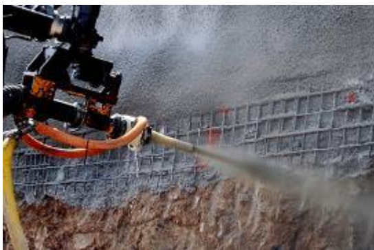
Fotografía 7 Implementación de concreto lanzado como la generación de capas de protección superficial
