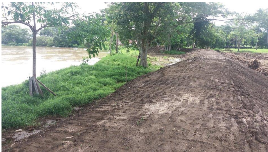
Construcción de diques para el control de erosión en (4) puntos críticos del río Sinú en el Corregimiento de Las Palomas.
