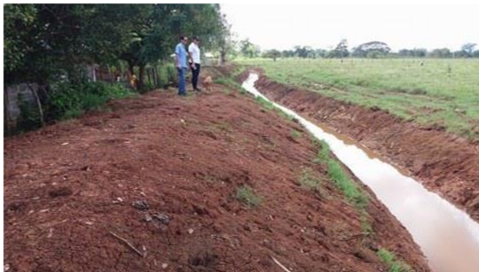
Construcción de dique y canal perimetral en la vereda Nuevo Reino, en el corregimiento Leticia, para proteger a más de 120 familias.
