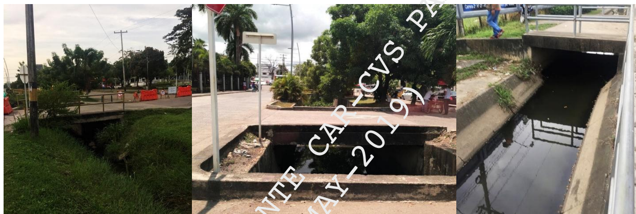
Fotografía 8. Condición de insuficiencia hidráulica de algunas estructuras sobre la red de drenaje urbano
