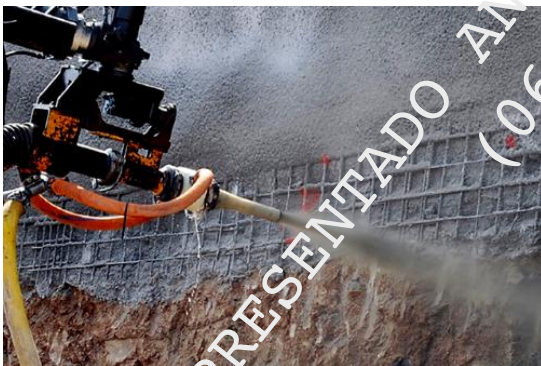
Fotografía 6. Implementación de concreto lanzado como la generación de capas de protección superficial
