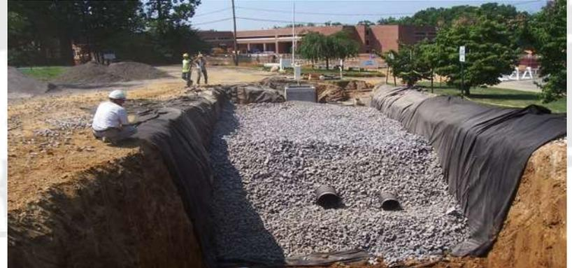
Pozos y Zanjas de Infiltración
