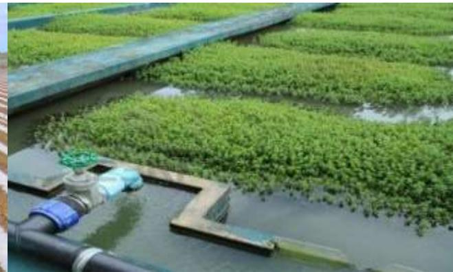
**Depurar y reutilizar el agua de riego y escorrentía** en parcelas agrícolas, mediante el empleo de un sistema combinado de tecnologías apropiadas de tratamiento natural: los humedales construidos y los buffer strip
