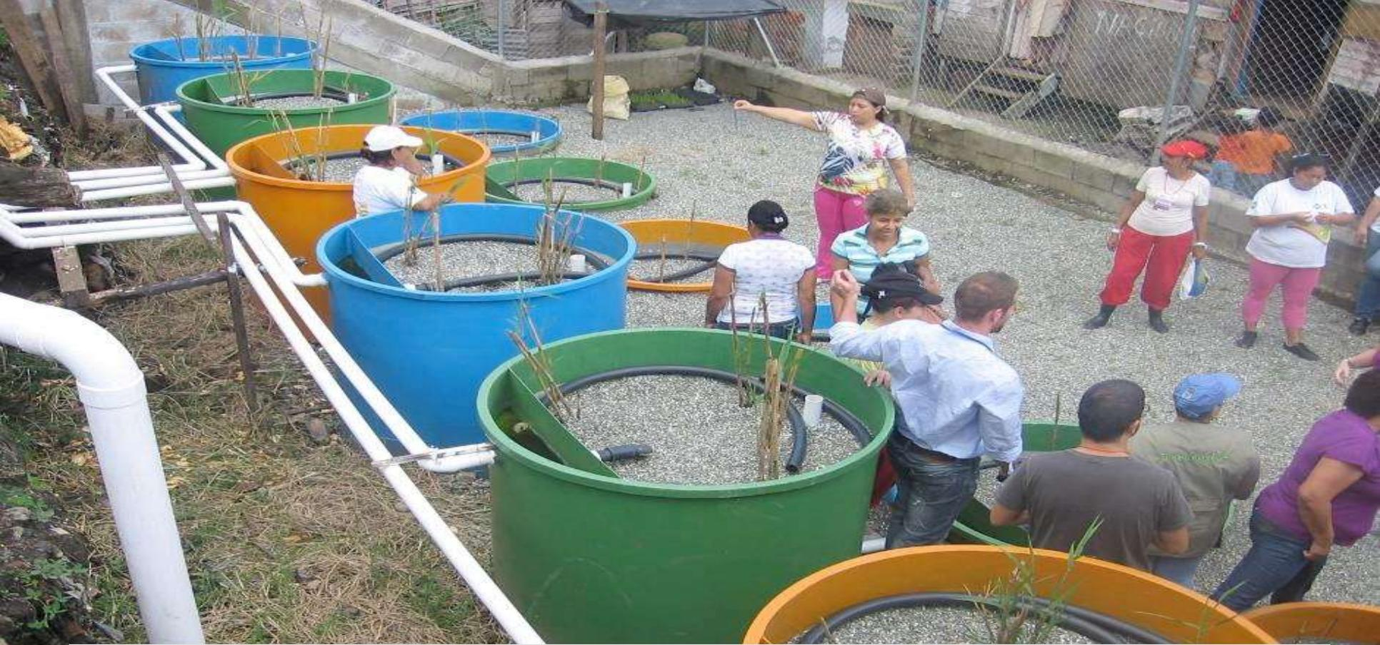
**PLANTA DE TRATAMIENTO DE LIXIVIADOS**, con humedales construidos de flujo subsuperficial vertical.
