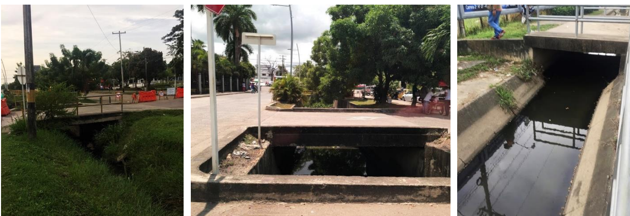
Fotografía 8. Condición de insuficiencia hidráulica de algunas estructuras sobre la red de drenaje urbano
